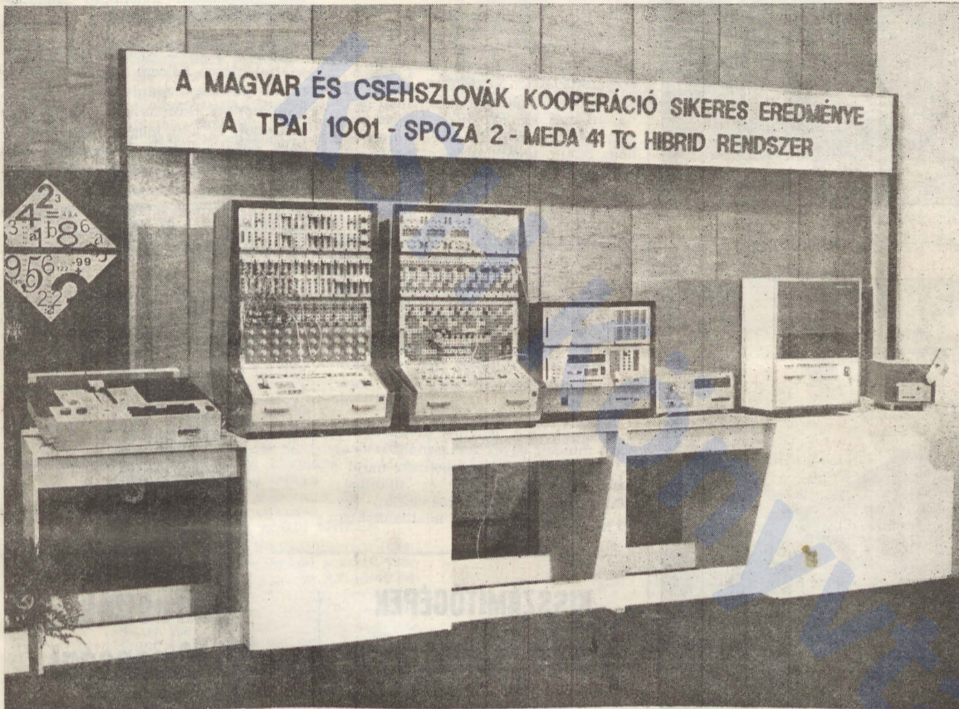
Csehszlovák gyártású analóg, és magyar digitális berendezésekből kialakított hibrid számítógép rendszer.
